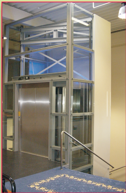
Kombinirani (steklo/beton) vozni jašek dvigala Objekt: Baloh Trzin Osebno dvigalo 1600 kg oz. 21 oseb
